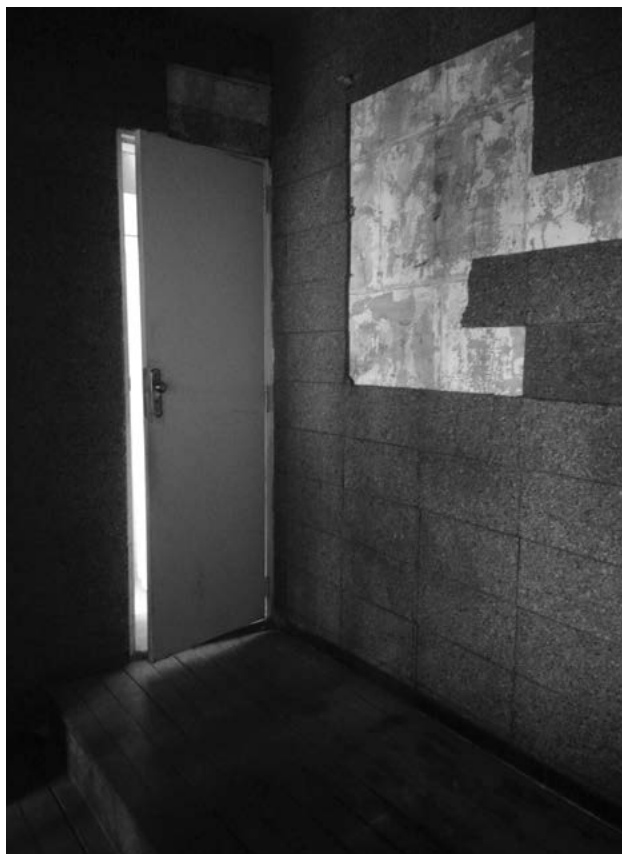
Figura 6.10. Sala das paredes de cortiça (6) vista de dentro. Foto da autora, maio de 2018.
