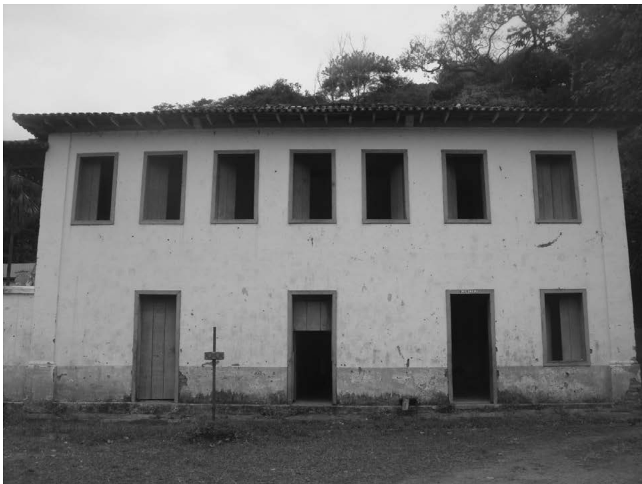
Figura 8.7. Fachada de la sede de la Fazenda Guarany . Fuente: autor
