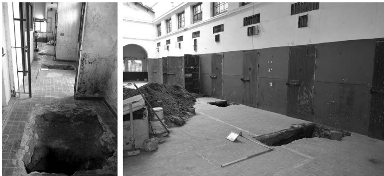
Figura 11.7. Detalles de las excavaciones realizadas por el GIAF en los años 2014 y 2015. Izquierda: sondeos en las cocinas, donde fueron localizadas las bóvedas de las antiguas bodegas. Derecha: sondeos en la sala de transacciones para comprobar la naturaleza de los parcheados del suelo de baldosas original (fotografías de los autores).
