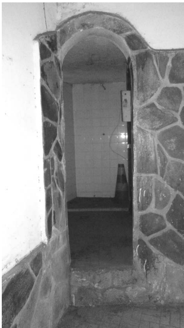
Figura 6.15. Detalhe da porta de entrada para o cômodo 32. Foto da autora, novembro de 2018.
