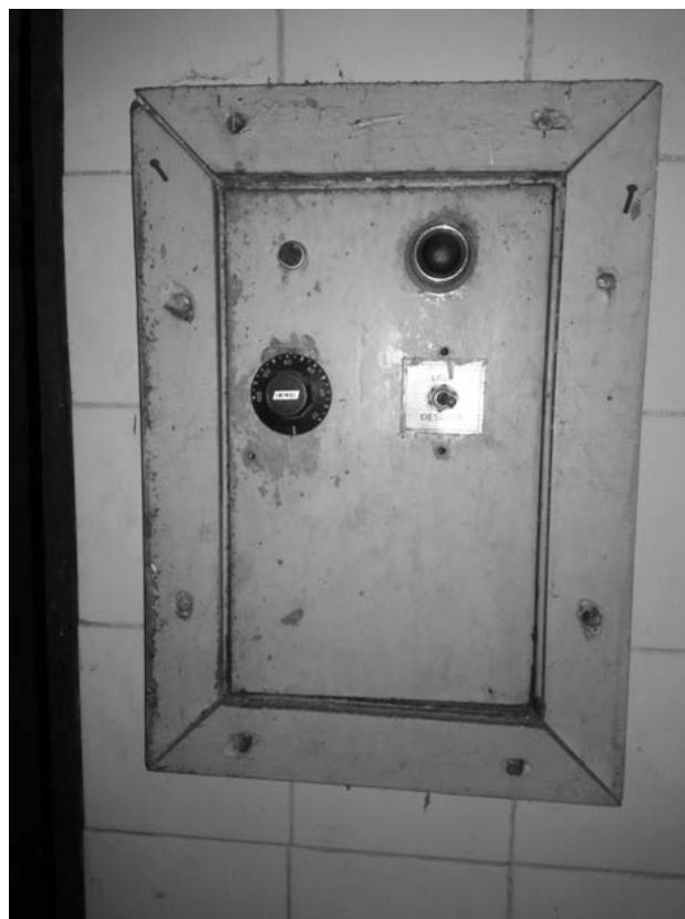
Figura 6.17. Termostato localizado no cômodo 32. Foto da autora, maio de 2018.
