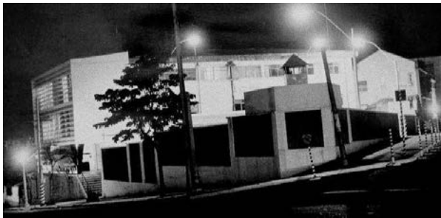
Figura 6.3. Foto noturna do DOPS-MG. Guarita lateral localizada na esquina da Avenida Afonso Pena e Avenida Bernardo Monteiro (IEPHA, 2015).
