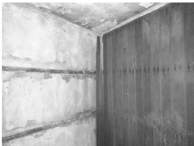
Figura 6.16. Detalhe dos vestígios do revestimento de madeira na 'sauna' (cômodo 33). Foto da autora, maio de 2018.
