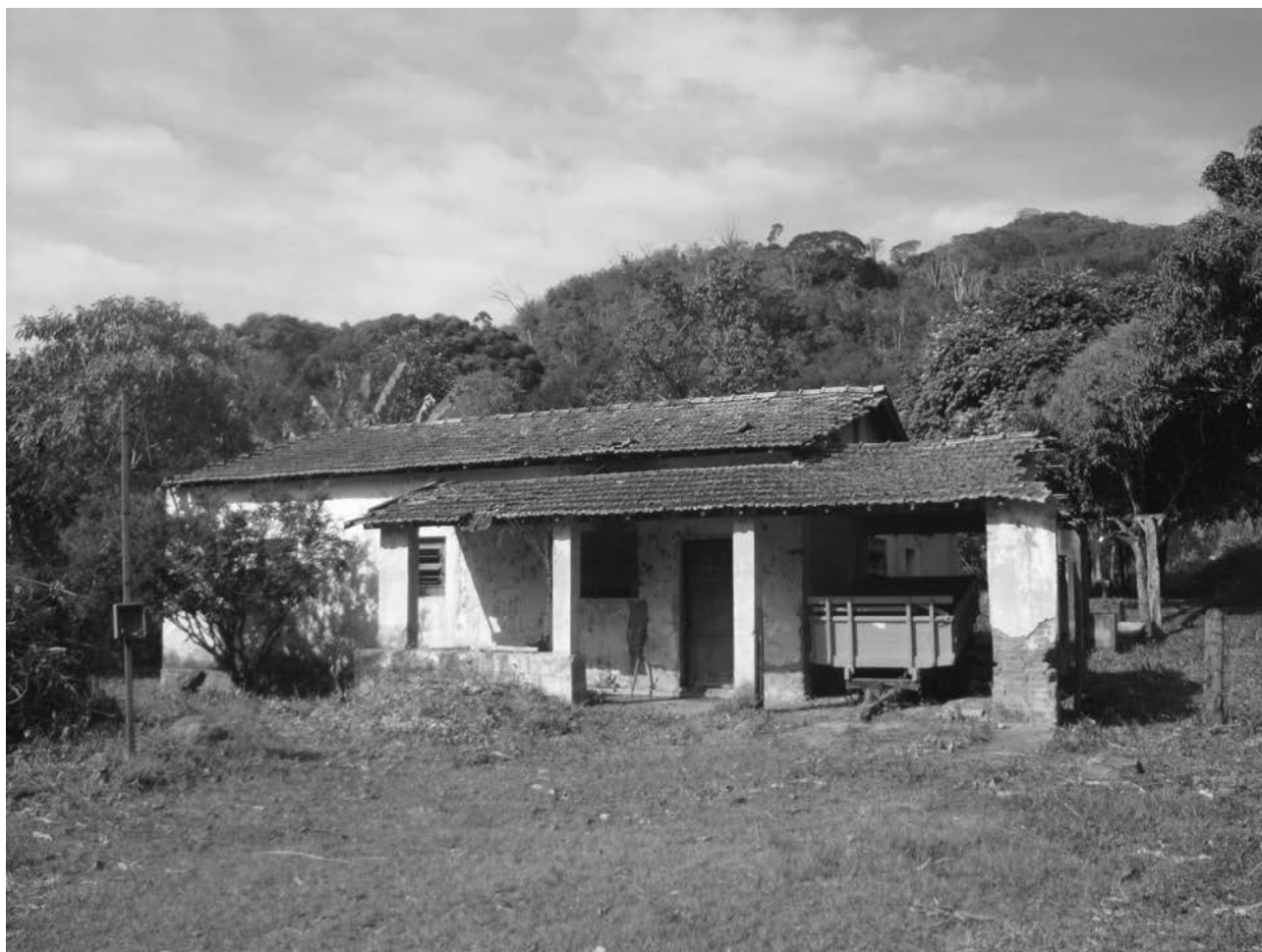
Figura 8.9. Una de las casas acondicionadas por los oficiales. Fuente: autor
